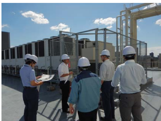
予備発電機の手動運転方法確認
